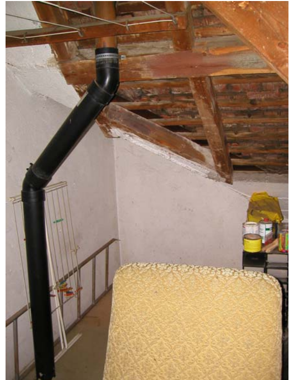
Primärentlüftungen Abwasser
