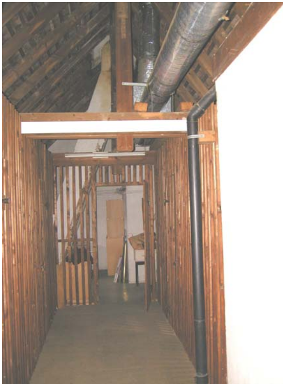
Abluftkanal über Kehlbalken geschleift
