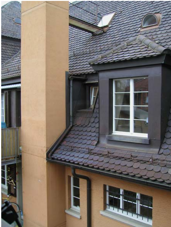
Hofseite mit Kamin neben Balkon von WHG links
